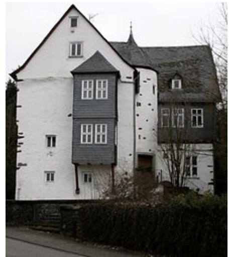
Langendernbach Hofhaus im Jahr 2009. Südwestseite.
