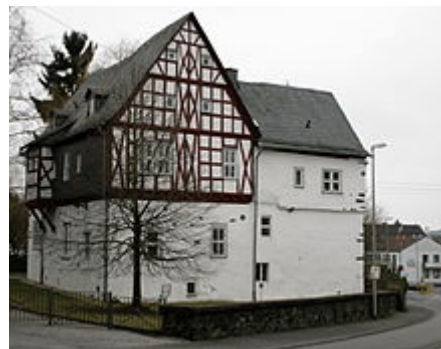
Langendernbach Hofhaus im Jahr 2009. Nordseite.
